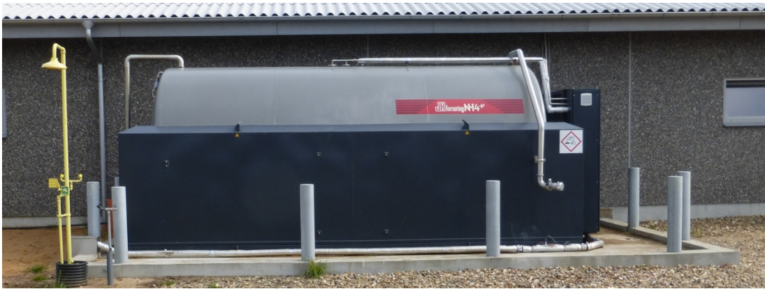
Figur 5. Stationär syratank omgiven av skyddspålar och dusch (JH Agro A/S).
