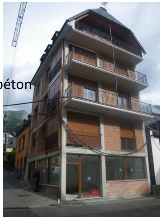
Voiles en béton, CPS
