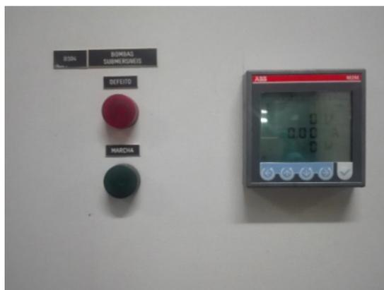
Figura 62. Analizador de energía instalado en la EDAR de Sobreiras.
