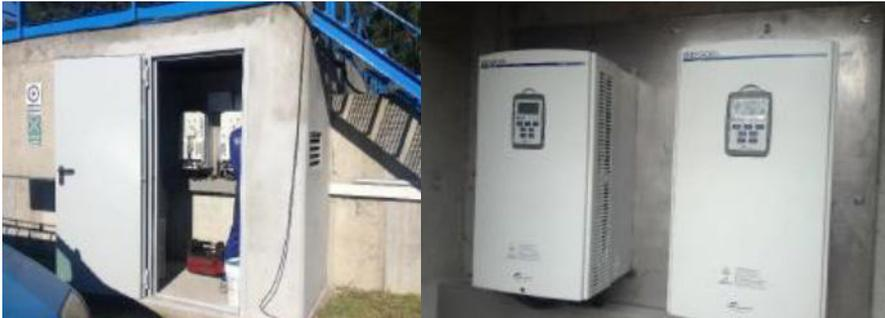
Figura 19. Convertidores de frecuencia colocados en la instalación.
