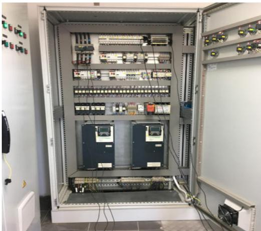
Figura 17: Convertidores de frecuencia para la regulación del caudal de las bombas de recirculación de la EDAR de Ribadumia.
