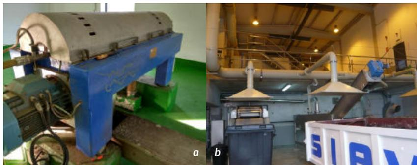
Figura 14: a) Centrifugadora, EDAR de Cedeira. b) Desodorización, EDAR de Ares.
