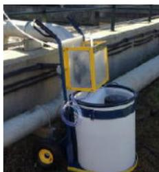
Figura 35. Aplicación de ácido fórmico en el circuito de aireación de la EDAR de Nigrán.
