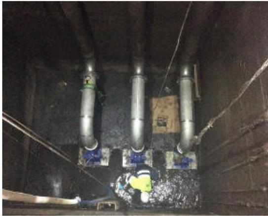
Figura 28. Bombas de elevación instaladas en la EDAR de Gondomar
