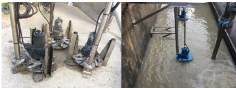
Figura 34. Aireadores sustituidos y los nuevos aireadores de burbujas finas, colocados en el tanque de pretratamiento.
