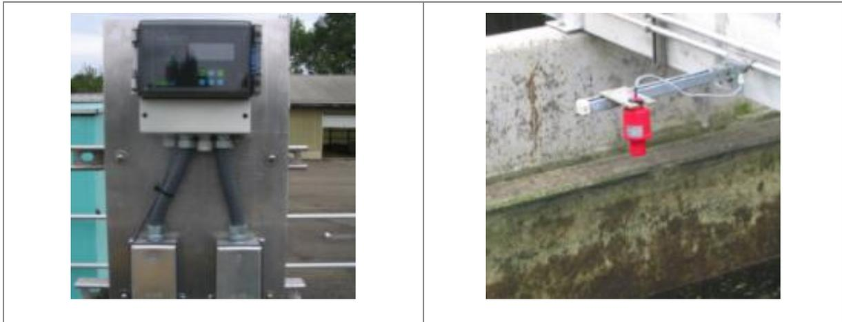
**Figura 15. Sensor de nivel por radar en EDAR. <sup>XV</sup>**
