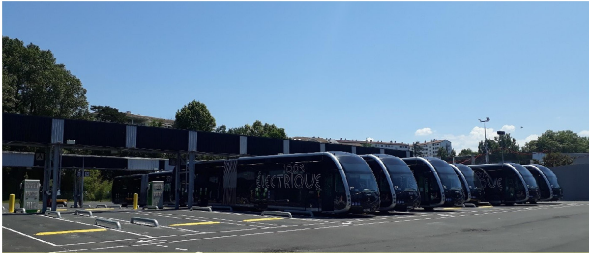
Plataforma de cargadores BRT finalizada
