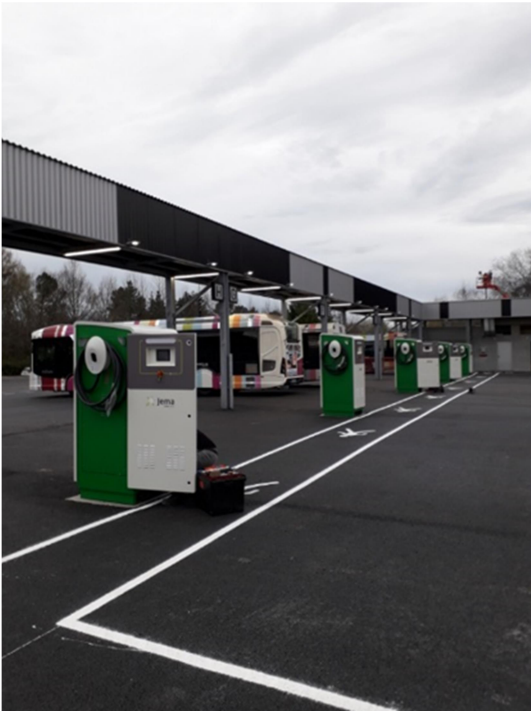
CHARGEURS EN COURS D'INSTALLATION SUR LA PLATEFORME BHNS
