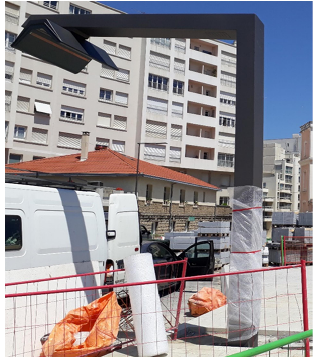
POSE DU MAT DE CHARGE A MAIRIE DE BIARRITZ
