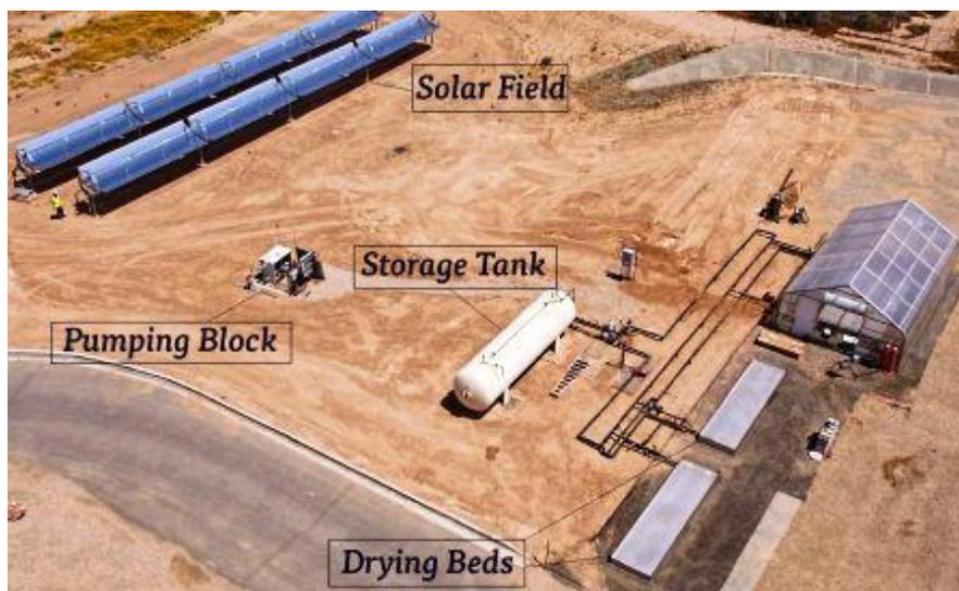
**Figura 14 - Estação de tratamento de águas residuais utilizando os concentradores cilindro parabólicos para a secagem das lamas. (Fonte: Helio CSP).**
