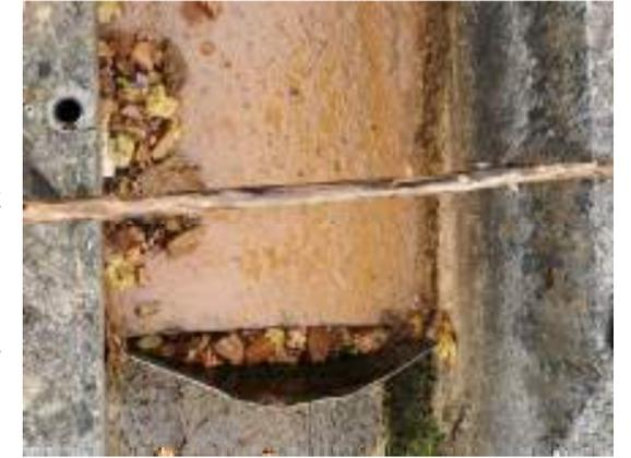
La nueva placa aforadora estará fabricada en acero inoxidable y tendrá las mismas dimensiones que la placa existente en la actualidad.
