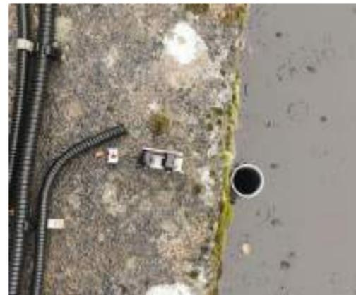
La presión de la columna de agua será aplicada a la capsula de forma directa, mediante inmersión, por lo que se exige instalar un tubo de PVC de diámetro interior no menor de 65 mm para que sea fácil la extracción del sensor para su mantenimiento.
