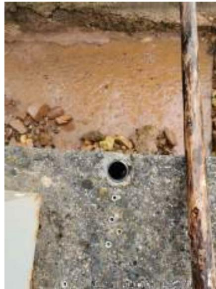
La nueva sonda se introducirá en el tubo de nueva construcción hasta alcanzar la solera del canal. Se tenderá un nuevo cableado que deberá terminar en el armario de control R001. El cable incluirá un tubo de compensación atmosférica que quedará abierto una vez se encuentre dentro de dicho armario.
