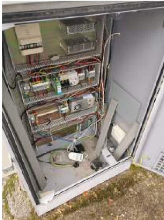
En este punto, se procederá a la dotación de una nueva batería hermética de Gel de 12 V y 172 Ah, que irá colocada en la parte inferior del armario de control.
