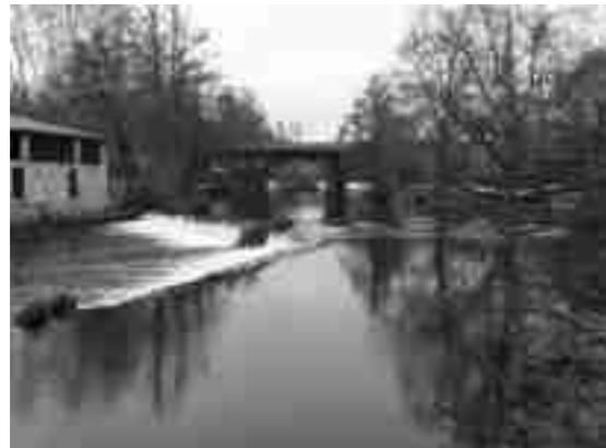
Se buscó un estrechamiento de sección ( como la obra de paso de la imagen ). Hubo problemas en cuanto a la disponibilidad de terrenos , y a la regulación del río aguas arriba del posible emplazamiento del sensor ( tramo regulado con varios azudes con compuertas ), por lo que al final se descartó este posible emplazamiento.
