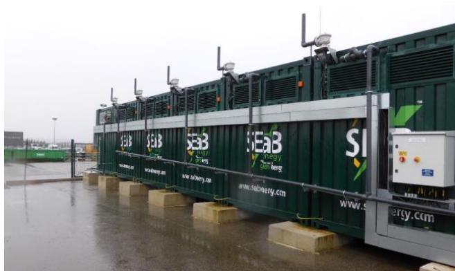
Figura 17. Foto del sistema Flexibuster™ instalado en la planta de SEPUR [44]
