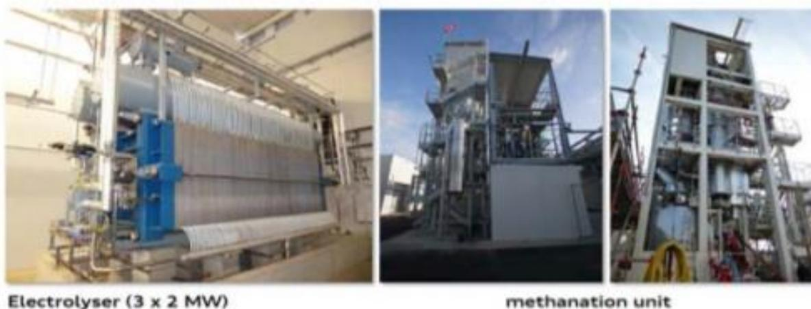
Figure 88 : Exemple d'unité de méthanation couplée à un électrolyseur de 6MW (AUDI)
