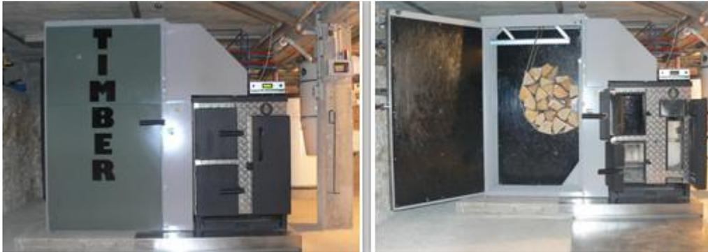
Figure 5 : exemple de chaudière à bûches automatique
