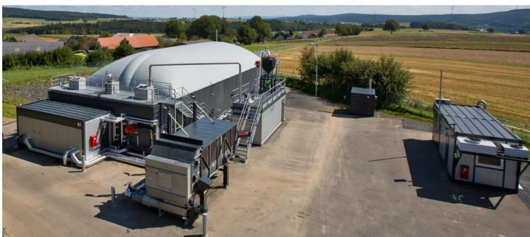
**Figure 45 : Méthaniseur voie sèche continue modulaire taille S (30-150 kWe) - BIOGASTIGER**
