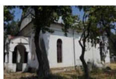
Biserica Adormirea Maicii Domnului - Radovan, Dolj Assumption Church - Radovan, Dolj Cod de identificare / Identification Code: 1406
