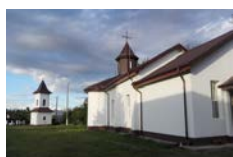
Biserica Sfântul Nicolae - Dor Marunt I, Călărași St. Nicholas Church - Dor Marunt I, Călărași Cod de identificare / Identification Code: 1261
