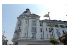
Blocul Casa Albă - Craiova, Dolj Block White House - Craiova, Dolj Cod de identificare / Identification Code: 1361
