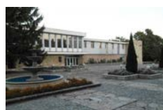
Casa de Cultură "Iluminarea" - Kula, Vazrajane, Vidin House of Culture "Enlightenment" - Kula, Vazrajane, Vidin Cod de identificare / Identification Code: 2616
