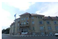
Primaria Giurgiu - Giurgiu, Giurgiu City Hall Giurgiu - Giurgiu, Giurgiu Cod de identificare / Identification Code: 1029
