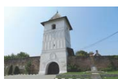
Mănăstirea Strehaia - Strehaia, Mehedinți Strehaia Monastery - Strehaia, Mehedinți Cod de identificare / Identification Code: 1492
