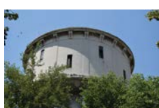
Turnul de apă - Turnu Măgurele, Teleorman Water Tower - Turnu Măgurele, Teleorman Cod de identificare / Identification Code: 1558
