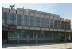
Teatrul de dramă Dragomir Asenov - Montana, Montana Drama Theatre Dragomir Asenov - Montana, Montana Cod de identificare / Identification Code: 2115
