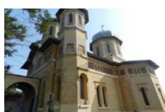
Biserica Sfinții Voievozi - Amărăștii de Jos, Dolj Church Holy Kings - Amărăștii de Jos, Dolj Cod de identificare / Identification Code: 1285
