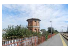
Turnul de apă - Murfatlar, Constanța Water Tower - Murfatlar, Constanța Cod de identificare / Identification Code: 1214
