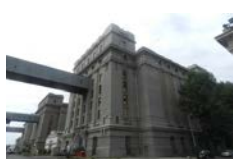
Silozurile Anghel Saligny - Constanța, Constanța Anghel Saligny Silos - Constanța, Constanța Cod de identificare / Identification Code: 1163
