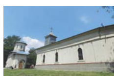
Biserica Sf Pantelimon - Vedea, Giurgiu Church of St. Panteleimon - Vedea, Giurgiu Cod de identificare / Identification Code: 1063
