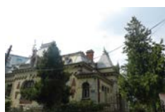
Casa Vernescu - Craiova, Dolj House Vernescu - Craiova, Dolj Cod de identificare / Identification Code: 1369
