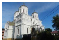
Biserica Adormirea Maicii Domnului - Cogealac, Constanța Assumption Church - Cogealac, Constanța Cod de identificare / Identification Code: 1075
