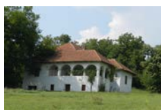
Conacul Radușeștilor - Butoiești, Mehedinți Radușeștilor Mansion - Butoiești, Mehedinți Cod de identificare / Identification Code: 1419
