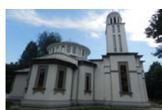
Biserica Înălțarea Domnului - Giurgiu, Giurgiu Ascension Church - Giurgiu, Giurgiu Cod de identificare / Identification Code: 1036
