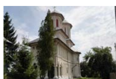
Biserica Adormirea Maicii Domnului - Colibași, Olt Assumption Church - Colibași, Olt Cod de identificare / Identification Code: 1605
