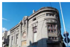
Casa Capitan Stanescu - Constanța, Constanța House Capitan Stanescu - Constanța, Constanța Cod de identificare / Identification Code: 1100
