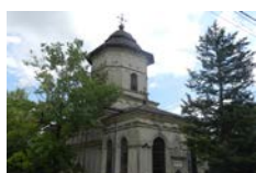
Biserica Sfântul Dumitru - Mănăstirea, Călărași St. Demetrius Church - Mănăstirea, Călărași Cod de identificare / Identification Code: 1265
