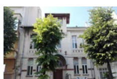
Casa Ing. Pâsla - Constanța, Constanța House of Engineer Pâsla - Constanța, Constanța Cod de identificare / Identification Code: 1107
