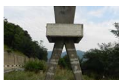
Monument Porțile de Fier - Porțile de Fier, Mehedinți Iron Gates Monument - Porțile de Fier, Mehedinți Cod de identificare / Identification Code: 1470
