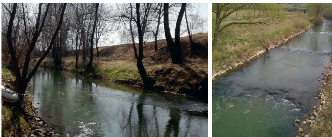
Manjša zaraščenost brežin in izoblikovan profil struge dolvodno od naselja Gregovce (levo) in stopnje dolvodno od krivine pred mejnim prehodom Rakovec (desno)
