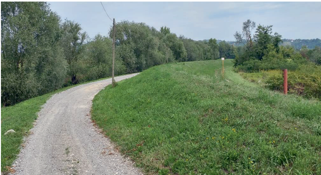
VV nasip pri Ključu Brdovečki (gledano gorvodno)
