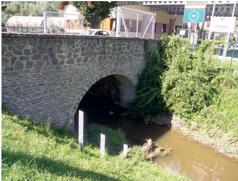
Poddimenzionirani most na Celjski cesti v Rogatcu in VP Hum na Sutli
