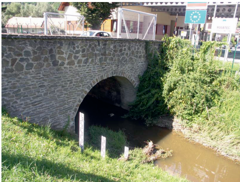
Poddimenzionirani most na Celjskoj cesti u Rogatcu i VP Hum na Sutli
