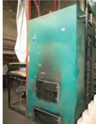
2.13. ATTĒLS: Granulu katls Zasas ciema kultūras namā. Katlu māja nodrošina ar siltumu pavisam 4 pašvaldības ēkas.
