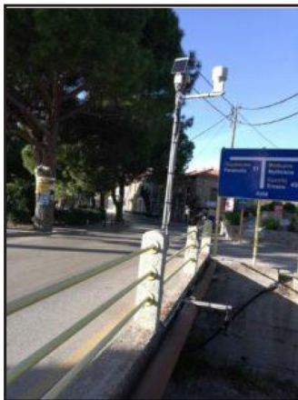
Αυτόματο καταγραφικό Σταθμός Καλλονής
